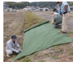
写真1：防草シートの設置作業状況
